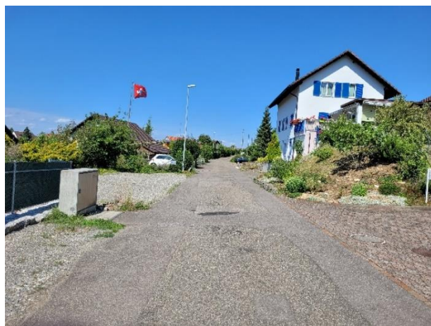
Abb. 2: Ansicht Grossacherweg, Ist-Zustand
